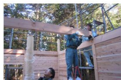
1階外壁が出来たら梁を載せる。室内にアラワシとなる柱は円形の廻り柱として、見た目にこだわっている。
