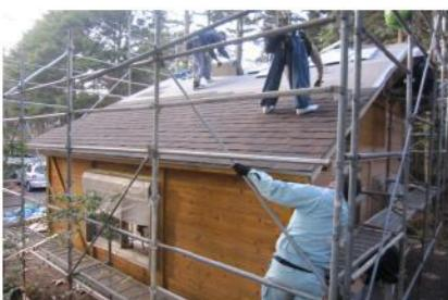
屋根に防水シートを敷き、アスファルトシングルを打って仕上げていく。この屋根材はけっこう重く、DIYでは苦労する部分。
