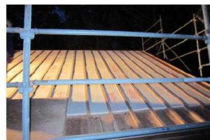
前の写真の板の上に断熱材を設置。外壁は1枚で断熱材はないが、雨が当たる騒音などの点からも屋根には必要となってくる。
