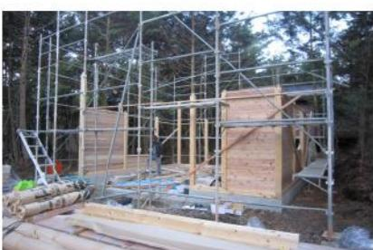
外壁は2×4のようにパネルを立てるのではなく、板を積み重ねていく。基本的にすべての外壁がこのような構造になる。
