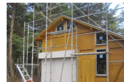
手動シャッターを設置して完成。この長谷川ガレージの場合、シャッターの中にフォールディングドアをオプションで設置している。
