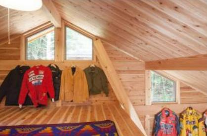
という、クルマ好きには「もうこれだけで十分!」と言わせるレイアウトだ。この板の間だが、実は固定されていない木の土台に板を敷いた構成。ロフトも板を敷いただけの構造だ。これはつまり、工事費用が安く上がるとともに、後々自分で好きなようにレイアウト変更することもできるということ。DIYする場合も大きなメリットだ。
