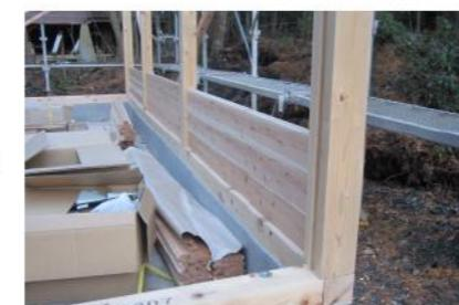
上下に凹凸がついた杉板の外壁を、柱の間に落とし込むようにして組んでいく。壁はこの外壁1枚の構造。
